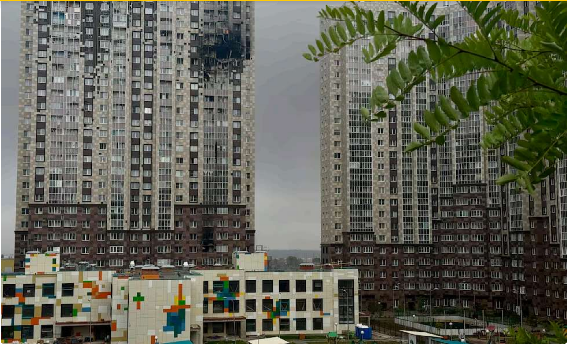
Un edificio de apartamentos de varias plantas dañado tras un ataque con drones en Kotelniki, en la región de Moscú, el 20 de septiembre de 2026. (Foto: AFP). / -
