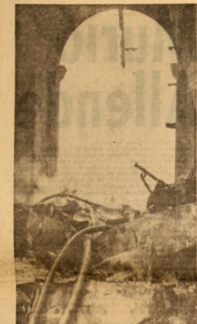
Esta escena capta patéticamente la destrucción causada en la puerta norte del Palacio de Gobierno, frente a la Plaza de la Constitución.
