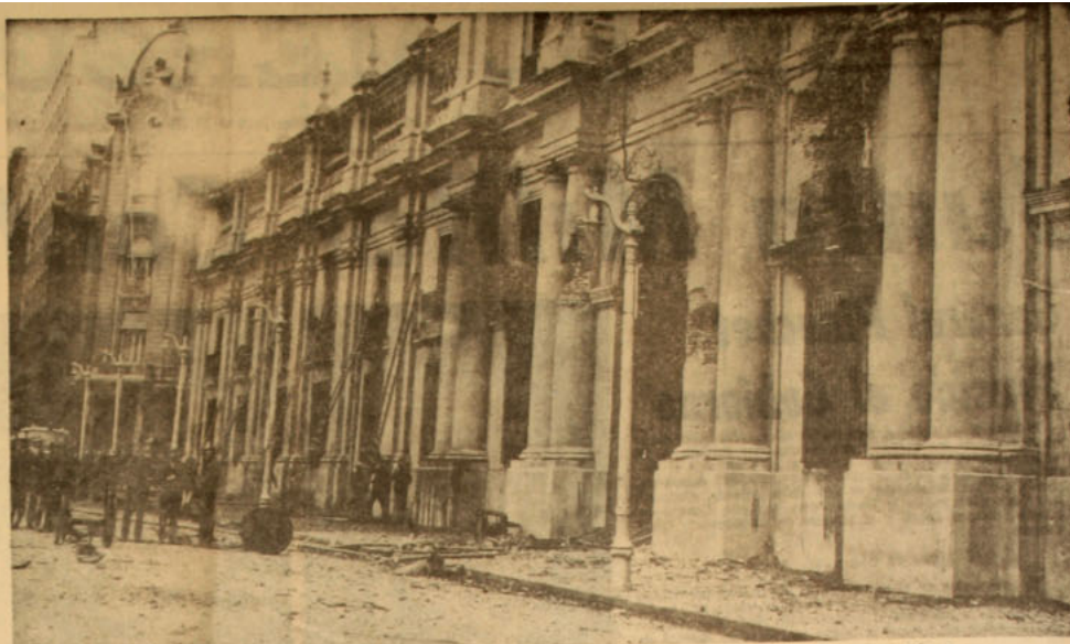
Otro aspecto del frontis del Palacio de la Moneda, por frente a la Plaza de la Constitución. Los muros están dañados por el fuego y las balas militares.
